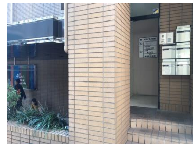
⑨ 左手に40MTビル別館玄関
